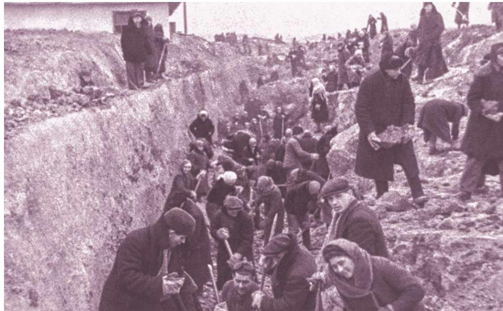
На строительстве Казанского обвода.
