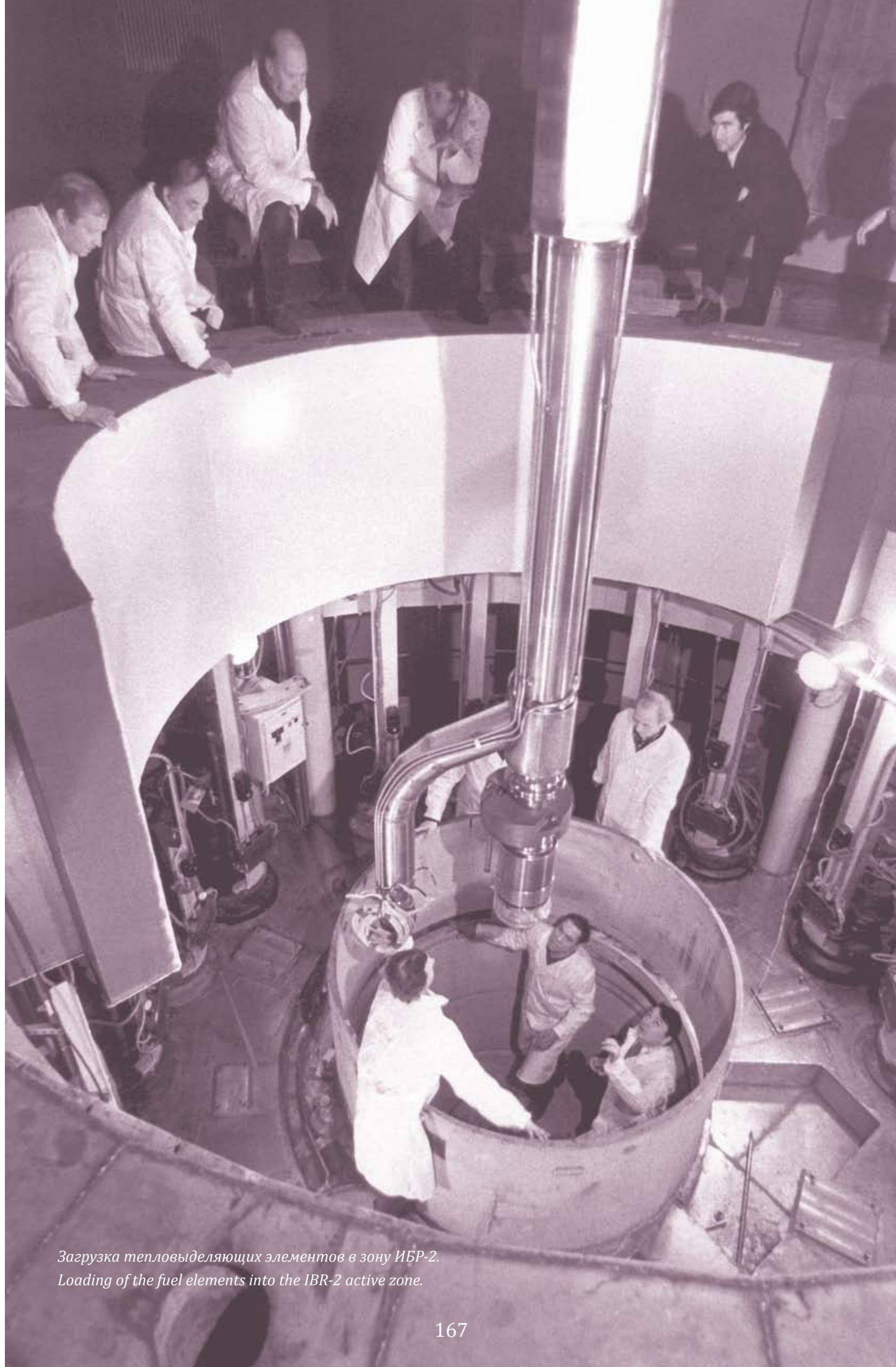
*Загрузка тепловыделяющих элементов в зону ИБР-2.
